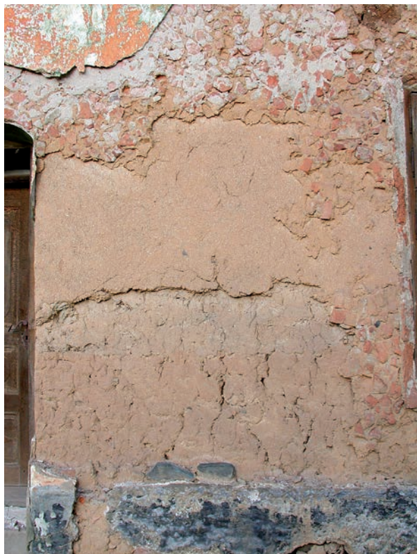
Enduit de terre incrusté d'éclats de céramique ; Pěnčíčky, distr. Přerov (Zuzana Syrová)
