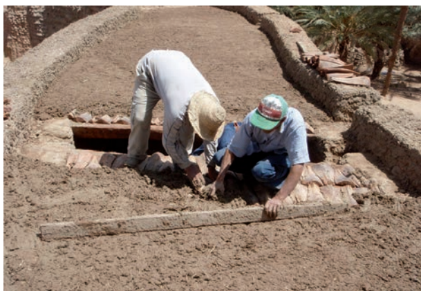
Réfection d'un plafond à Figuig, Maroc (J.-M. Gentilleau 2008)
