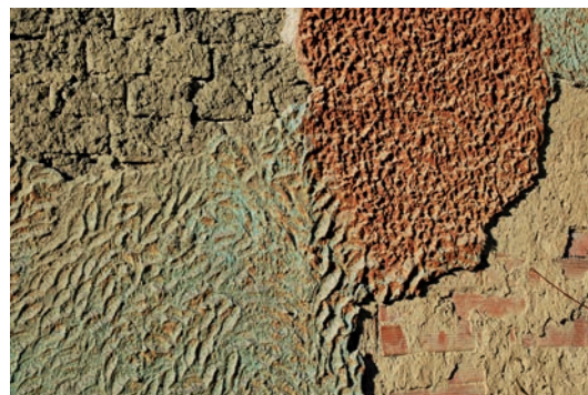
Différents traitements de surface de l'enduit frais, avec un balai et une spatule ou cuillère, largement utilisé en cas d'enduits de terre ainsi que ceux à la chaux depuis la fin du 19 e siècle ; Kněždub, distr. Uherské Hradiště (Zuzana Syrová)
