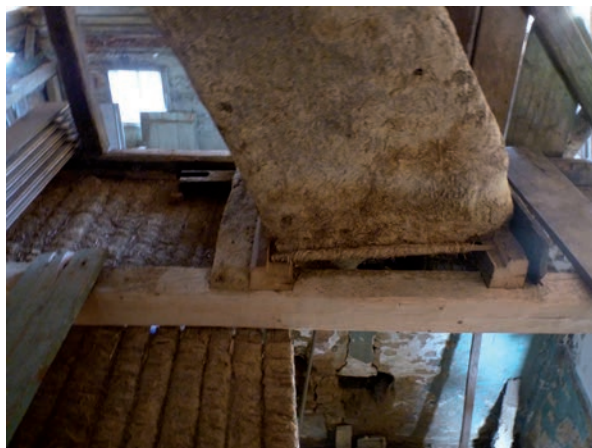
1 - Bois empilé emboîté couvert d'une couche de terre incrustée d'éclats de céramique ; Damníkov, distr. Svitavy (Zuzana Syrová)
