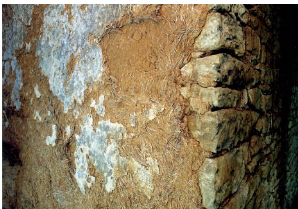
Enduit de terre d'un mur en pierre du 17 e siècle ; Čistá u Litomyšle, distr. Svitavy (Jiří Škabrada)
