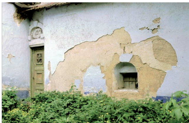
Enduit de terre d'un mur en pisé ; Jankovice, distr. Uherské Hradiště (Zuzana Syrová)
