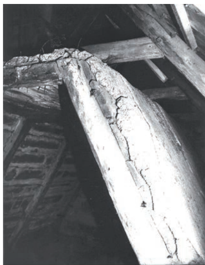
1 - Bois empilé emboîté couvert d'une couche de terre incrustée d'éclats de céramique ; Damníkov, distr. Svitavy (Zuzana Syrová)
