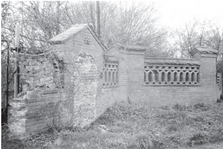
Materiály a konstrukce: drážková kce, nabíjení. nepálená cihla, pálená cihla
