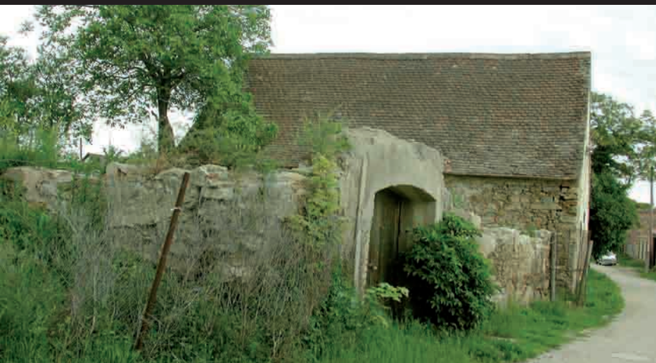
* Šatov (Schattau), okres / Bezirk Znojmo (Znaim): Lisovny z 18.století s patrnými technologickými vrstvami, osekáným povrchem stěn a zaoblením nároží * stav 1995 / 2006; Šatov, okr. Znojmo * granulometrie odebraných vzorků (Jan Kříž)
