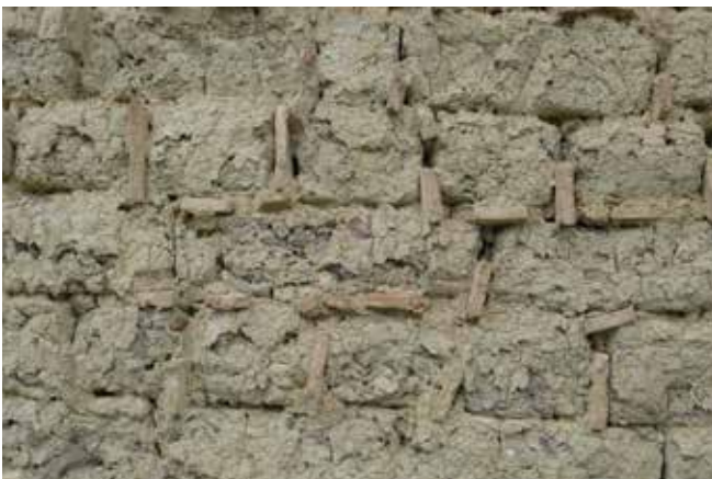
Fig. 2 : Enduit de terre d'un mur en pisé incisé de rainures diagonales. Jankovice n° 101, distr. Uherské Hradiště (Z. Syrová).
