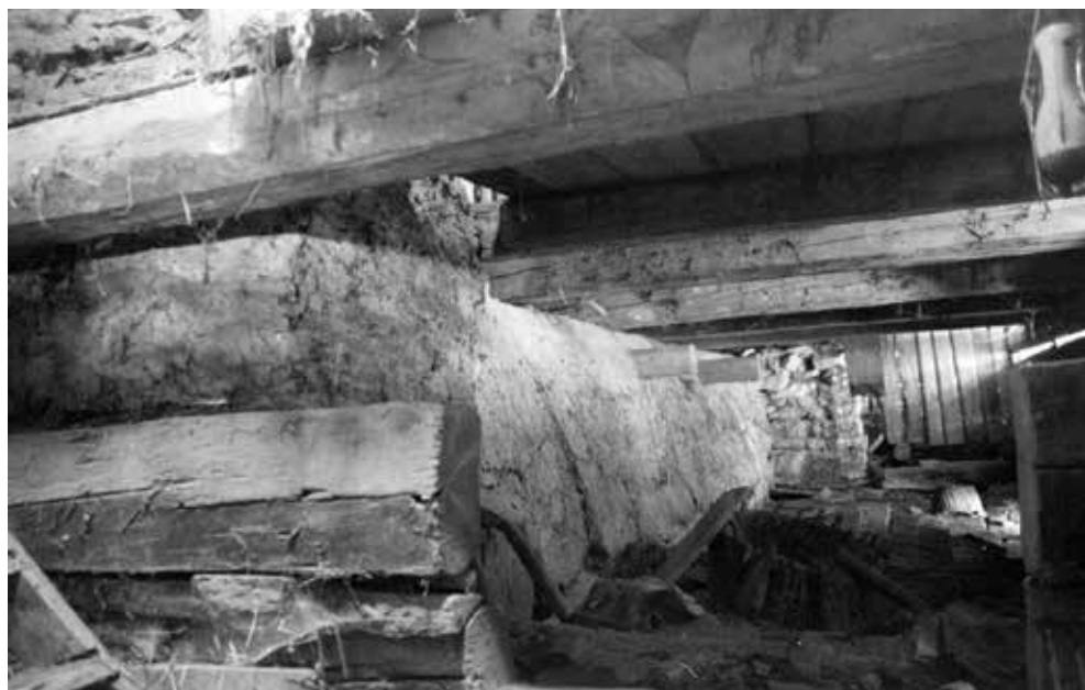
Fig. 19 : Partie supérieure d'une pièce d'habitation claire, datée 1702, à plafond et murs en rondins revêtus de terre. Čistá n° 33, distr. Svitavy (Z. Syrová).
