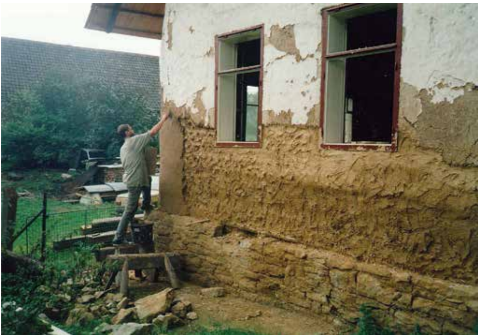
Fig. 32 : Réfection du garnissage et du revêtement de terre pendant les travaux de restauration. La terre et le mélange pour la couverture ont été choisis et conçus dans le cadre du projet Analyses des matériaux des constructions historiques (Kříž, Vorel 1988 ; Syrová et al. 2000) Čistá n°171, distr. Svitavy (J. Kříž).
