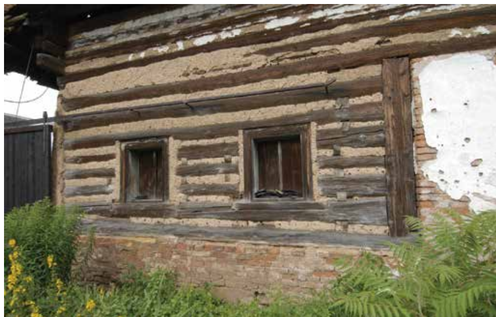
Fig. 7 : Maison de ferme, bâtie vers 1775, en bois empilé emboîté dont les joints horizontaux sont garnis de torchis maintenu par des chevilles en bois. Les façades ont été ensuite simplement blanchies à la chaux. Rychnov na Moravě n° 137, distr. Svitavy (Z. Syrová).
