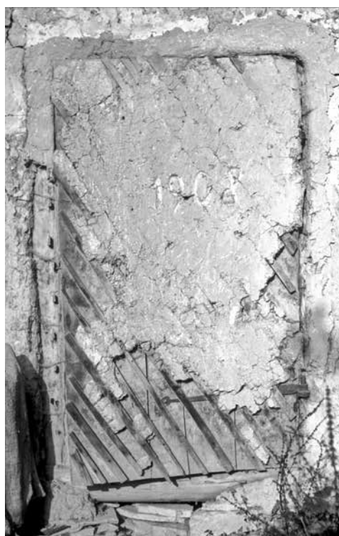
Fig. 30 : Revêtement de terre, portant la datation de 1908, sur le vantaill et l'encadrement de porte d'un grenier séparé. La terre permet d'isoler l'ensemble du bâtiment, y compris la porte, contre l'incendie et de maintenir un microclimat stable à l'intérieur. Ce type de portes de grenier, dont l'assemblage particulier nécessite une protection de terre, est uniquement documenté à l'est de la Slovaquie. Lenartov, Slovaquie (Z. Syrová).
