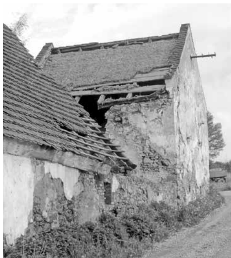
Fig. 22 : Revêtement en lepenec à la surface du voligeage jointif de couverture d'un grenier isolé, visible après l'enlèvement de la charpente supérieure du toit. Zábोří, distr. České Budějovice (Z. Syrová).
