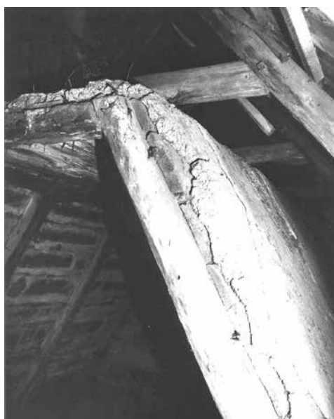
Fig. 26 : Surface décorée d'un torchis de hourdis, datée 1783. Šluknov, distr. Děčín (Z. Syrová).
