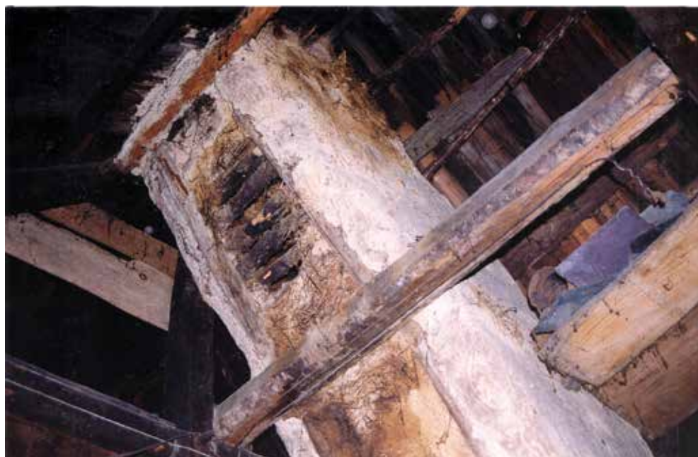
Fig. 29 : Conduit d'une cheminée en bois construit à la fin du XVIII e siècle, recouvert d'une couche protectrice de terre en prévention des incendies. Šluknov n° 310, rue Karlova, distr. Děčín (K. Kroulíková).
