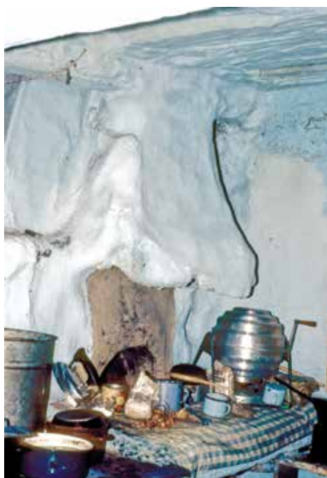
Fig. 18 : Hotte en clayonnage enduite à la terre installée au-dessus de l'ancien foyer devant la bouche du four en 1988. Študlov n° 82, distr. Vsetín (Z. Syrová).
