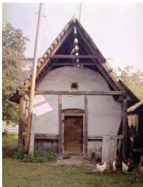
Fig. 12 : Grenier séparé construit en bois empilé emboîté, couvert avec une fausse voûte d'arêtes, entièrement recouvert de terre. La toiture qui protège l'ensemble est portée par une structure indépendante. Lenartov, Slovaquie (Z. Syrová).
