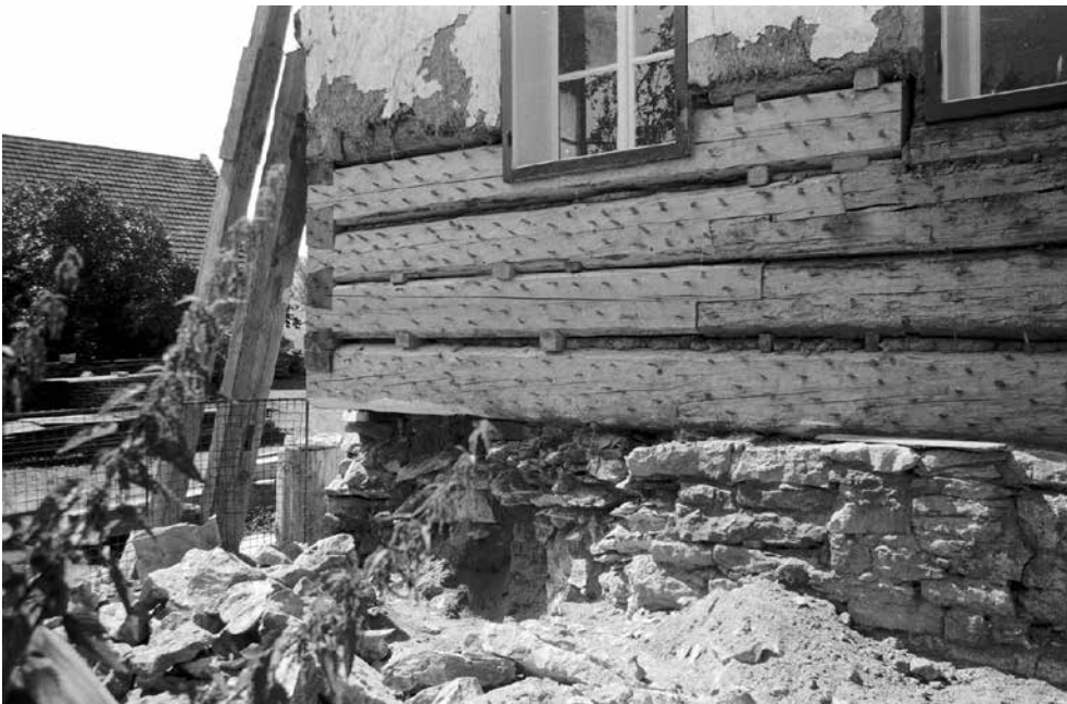
Fig. 31 : Remplacement depuis l'extérieur des poutres inférieures, munies de chevilles en bois pour l'accrochage du revêtement. Čistá n° 171, distr. Svitavy (Z. Syrová).
