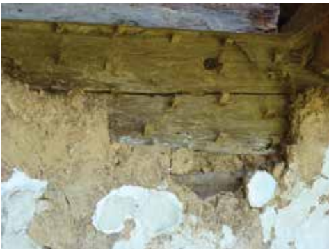
Fig. 9 : Assemblage de l'angle du bâtiment avec son épaisse garniture de terre dans les joints horizontaux. Les façades ont été blanchies à la chaux à plusieurs reprises. Vír, distr. Žďár nad Sázavou (Z. Syrová).
