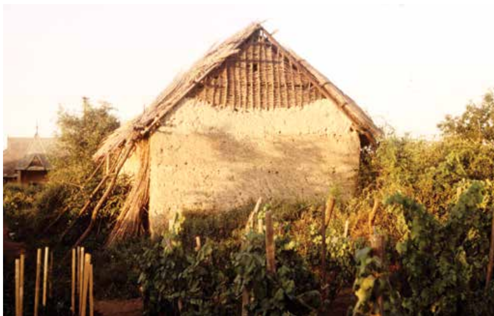
Fig. 2 : Pressoir à vin construit en bauge montée à la fourche avec un pignon tressé partiellement couvert de torchis. Dolný Peter, Slovaquie (Z. Syrová).
