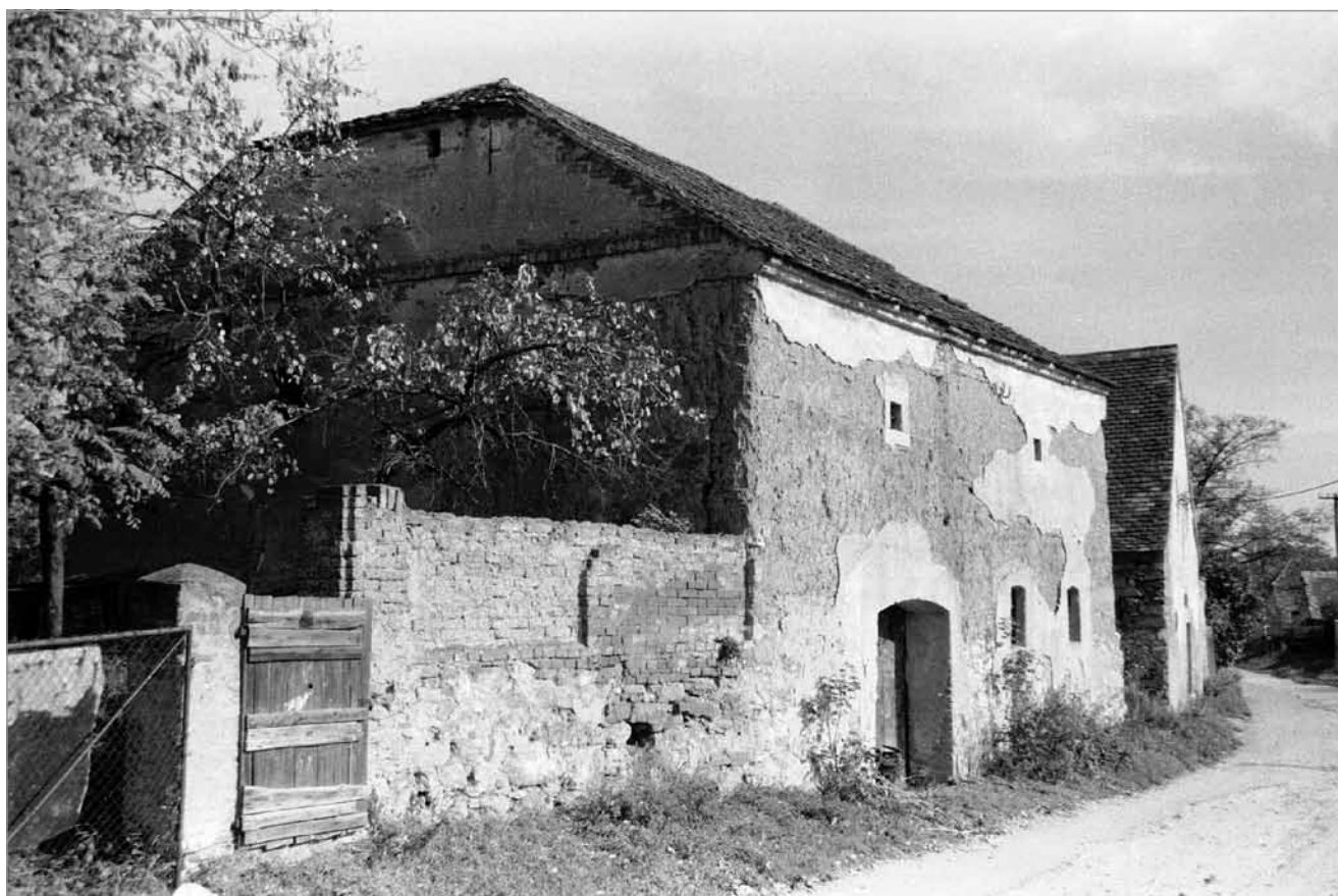
Obr. 4) Lisovna se stěnami z masivní vrstvené nepálené hlíny v Šatově, okr. Znojmo (foto Z. Srová 1995).
