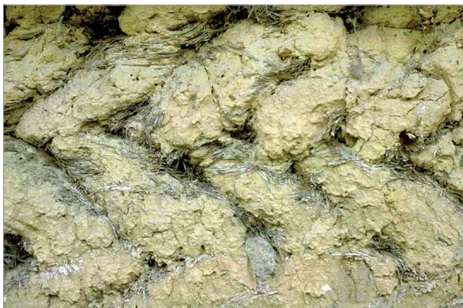
Obr. 5) Detail stěny z vrstvených válků ručně klasovitě kladených, Němčice nad Hanou, okr. Prostějov (foto Z. Syrová 1987).
