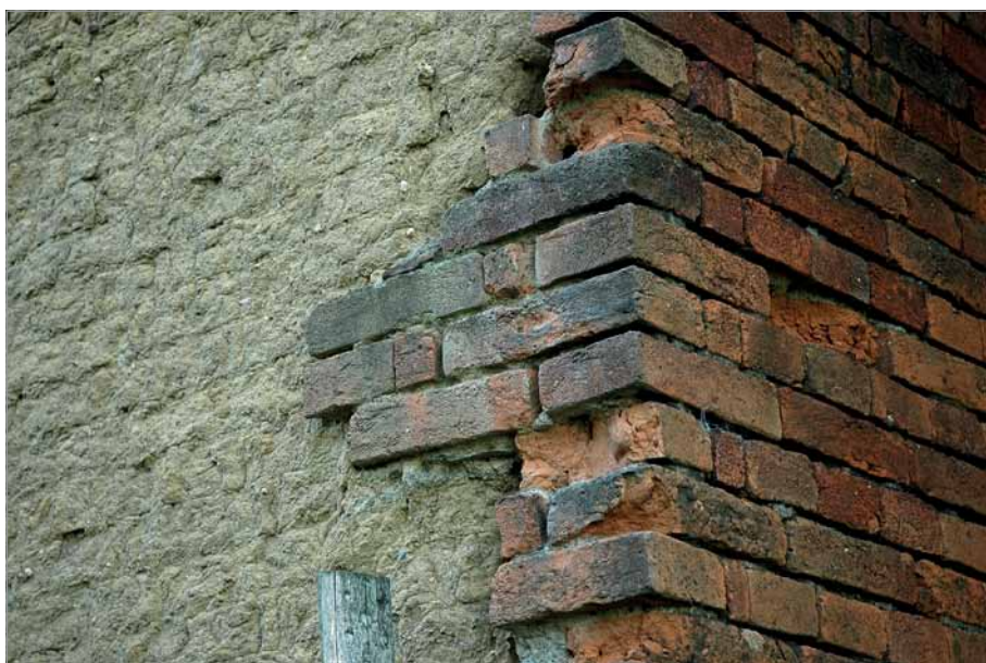
Obr. 11) Detail nároží s obkladem z pálených cihel z oblasti Hané, Rataje, okr. Olomouc (foto Z. Sýrová 2005).
