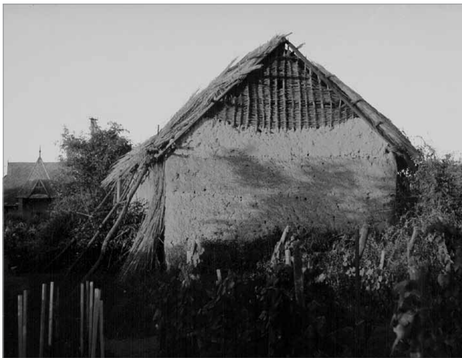
Obr. 3) Vinná buda se stěnami vrstvenými z hlíny nakládané vidlemi, Dolný Peter, Slovensko (foto Z. Syrová 1990).
