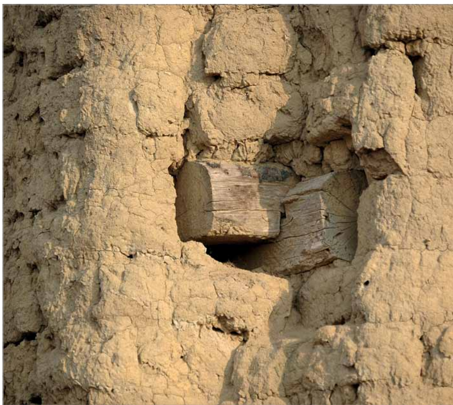
Obr. 2) Dřevěná armatura na nároží stodoly z nepálených cihel, Hroznová Lhota, okr. Hodonín (foto Z. Syrová 2012).
