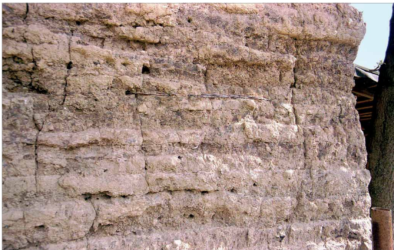
Obr. 7) Stěna stodoly nabíjené z hlíny pomocí bednění bez příčníků s vrstvami proloženými proutím, Jankovice, okr. Uherské Hradiště (foto Z. Syrová 2000).
