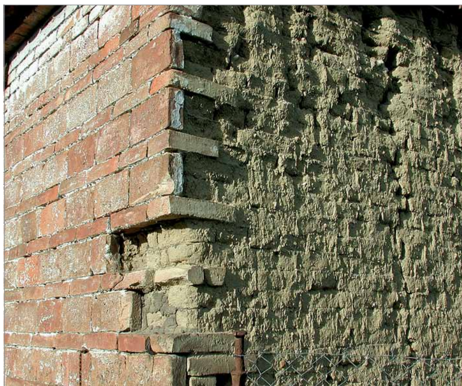
Obr. 12) Detail nároží stodoly u čp. 123 s obkladem z pálených cihel ze Znojemska, Mackovice, okr. Znojmo (foto Z. Syrová 2001).
