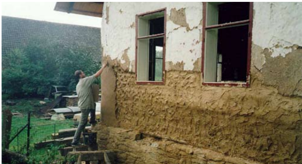
Abb. 1: Erneuerung des äußeren Lehmverputzes an der gezimmerten Rauchstube im Haus Nr. 171 in Čistá (Bezirk Svitavy); der obere Teil bis in die Fensterbankhöhe aus dem Ende des 16. Jhdts., Foto: Jan Kříž 1998
