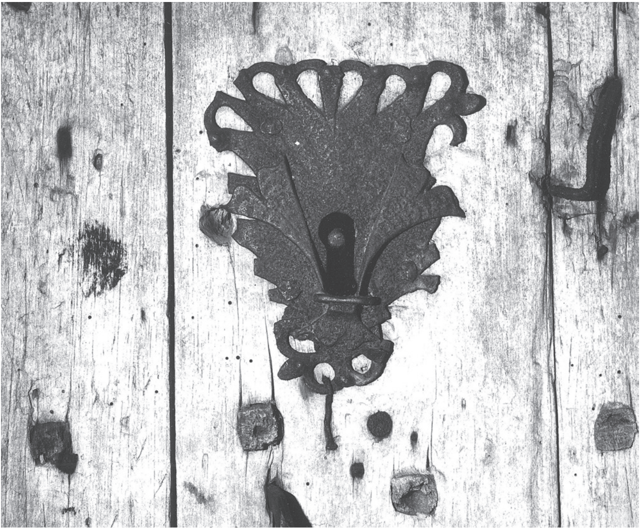
Radostice u Zlaté Koruny čp. 1
