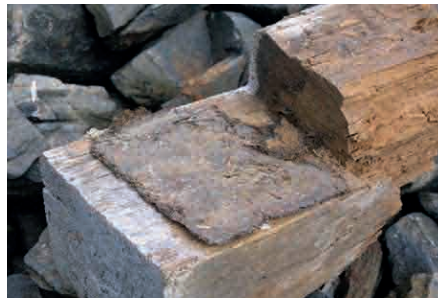
↑ Eš u Pacova čp. 20 – mechová vložka, nalezená v rybinových vazbách při rekonstrukci roubené světnice chalupy (JŠ 2004).
