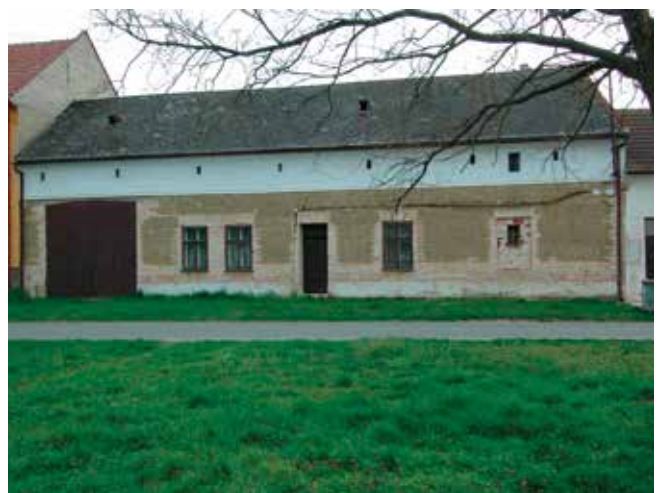
Fig. 14 : Maison de ferme lors des travaux de rénovation de la façade, qui ont permis l'identification de la maçonnerie en brique crue. Kvačice, distr. Uherské Hradiště (Z. Syrová).
