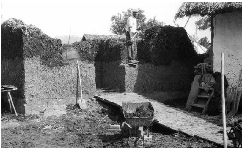
Fig. 20 : Construction en bauge montée à la fourche à Martovce (Slovaquie) vers 1950 (Václav Mencl, collection privée de Roman Tykal).
