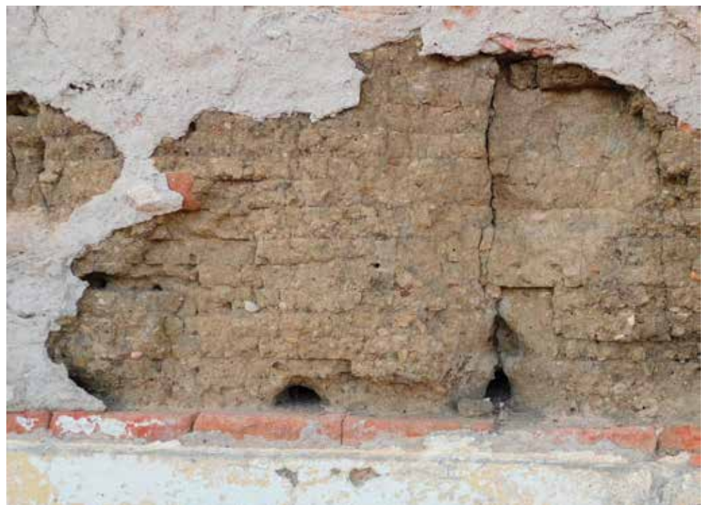
Fig. 9 : Détail d'un mur en pisé des étables de Hildegardin dvůr. Pohořelice, Velký Dvůr no 223, distr. Brno-venkov (Z. Syrová).
