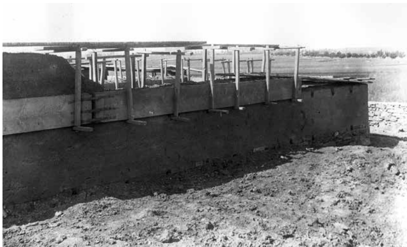
Fig. 19 : Construction en pisé à Hroznová Lhota, distr. Hodonín, en 1910 (Karel Chotek, collection privée de Roman Tykal).
