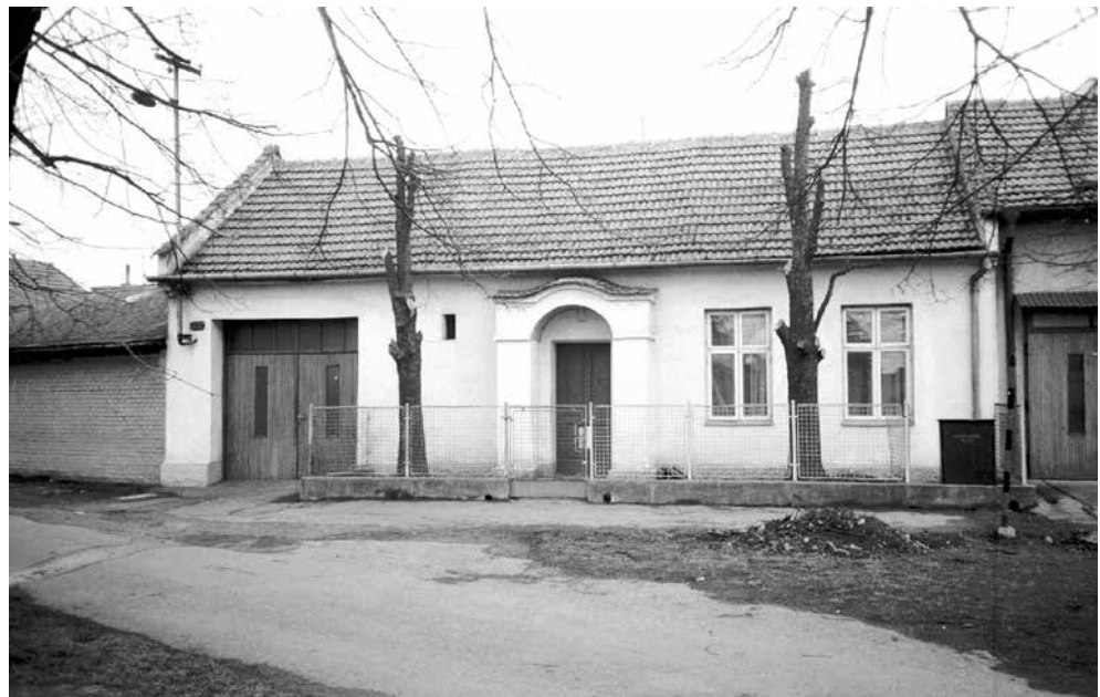
Fig. 16 : Maison-type à porche (žudro) du quartier Na Láně (état avant la reconstruction de 1994). Ostrožské Předměstí, distr. Uherské Hradiště (Z. Syrová).
