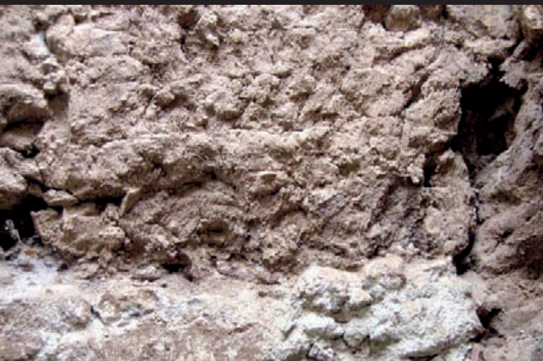
VRSTVENÁ HLÍNA / NAKLÁDÁNÍ / VRSTVENÉ VÁLKY: Vrstvení hliněných hrud * Francie: bauge / mottes de terre, pains de terre; gleba lutea: .hliněné bochníky z 15. a 10. - 11. stol.; neuspočádané hroudy - 14. století - archeologické nálezy z oblasti Languedoc - Roussillon * vernakulární stavby z 18.-19. století z okolí Toulouse
