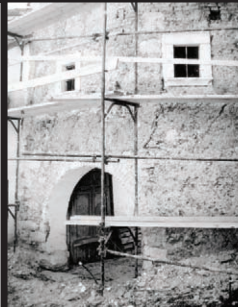
VRSTVENÁ HLÍNA / NAKLÁDÁNÍ / VRSTVENÉ VÁLKY: Vrstvení hliněných hrud * Dolní Rakousy: termín Wuzel / Wutzel / Wuzelmäuern / Batzbau * příklad Brandlhof, Radlbrunn, 16. stol. ? // vrstvená hlína a války
