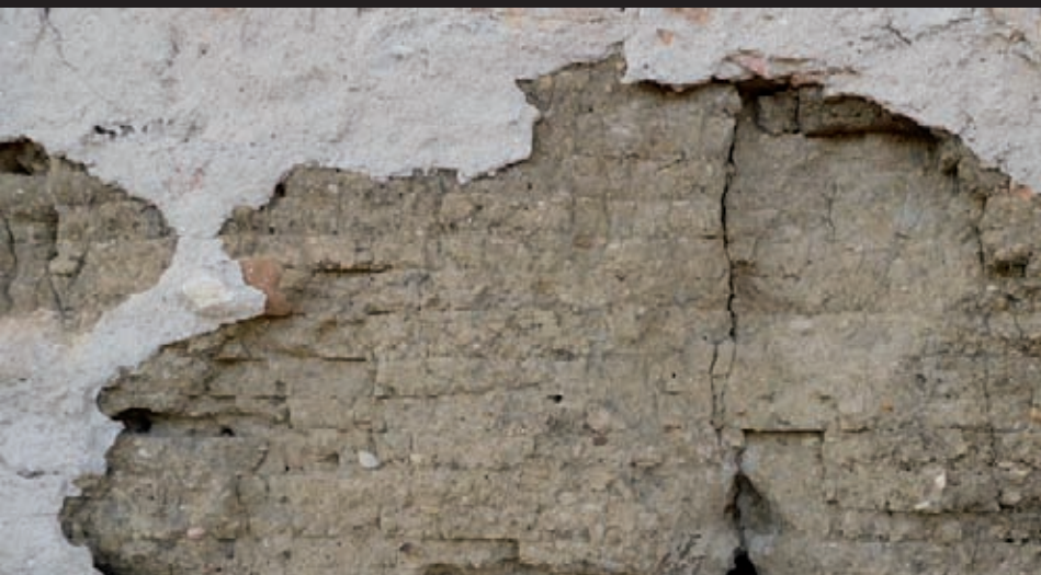
TRAKTÁRY A PŘÍRUČKY STAVITELSKÉ - VLIV: Hlína dusaná do bednění - Hildegardin dvůr kol. r. 1835; Pohořelice, Velký Dvůr čp. 223 * Úprava spar pro lepší přichycení omítky - Unterretzbach, Dolní Rakousy
