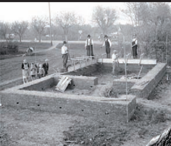
DUSANÁ HLÍNA / NABÍJENICE: Bedněň s příčňíky: Stavba pisé podle Rondeleta (1812) * Nástroje pro pisé podle Rondeleta (CRATerre) * Bedněň z Auvergne podle CRATerre * Stavba z dusané hlíny kolem roku 1930 v Maďarsku.
