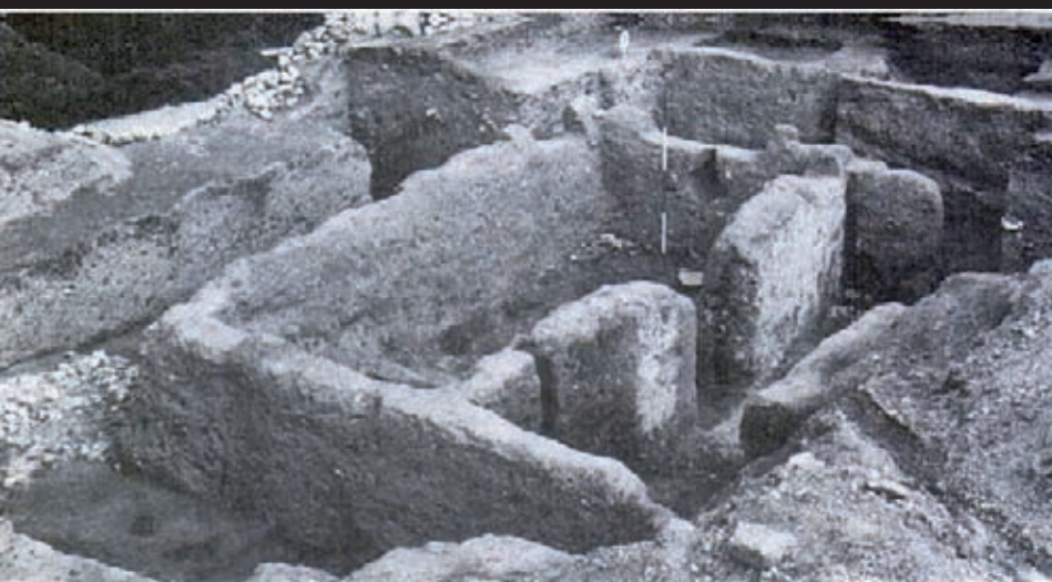
DUSANÁ NEBO VRSTVENÁ HLÍNA ?: Angle: Wallingford Castle (Oxfordshire); Robert Carr 1972 - stěny budovy o půdorysných rozměrech 8,5 x 12,5 m ze druhé poloviny 12. - počátku 13. století postavené technikou vrstvené hlíny „cob“ zachovány do výšky 1,8m (Chapelot Fossier 1980 Le Village et la maison au Moyen Age uvádějí jako příklad „pisé“)
