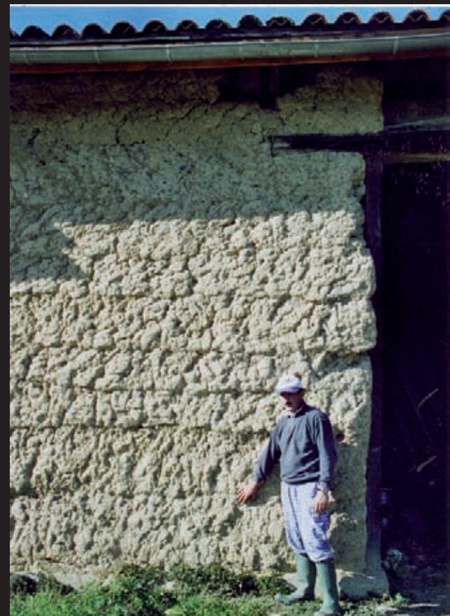
VRSTVENÁ HLÍNA / NAKLÁDÁNÍ / VRSTVENÉ VÁLKY: Vrstvení hliněných hrud * Francie: bauge / mottes de terre, pains de terre; gleba lutea: .hliněné bochníky z 15. a 10. - 11. stol.; neuspočádané hroudy - 14. století - archeologické nálezy z oblasti Languedoc - Roussillon * vernakulární stavby z 18.-19. století z okolí Toulouse
