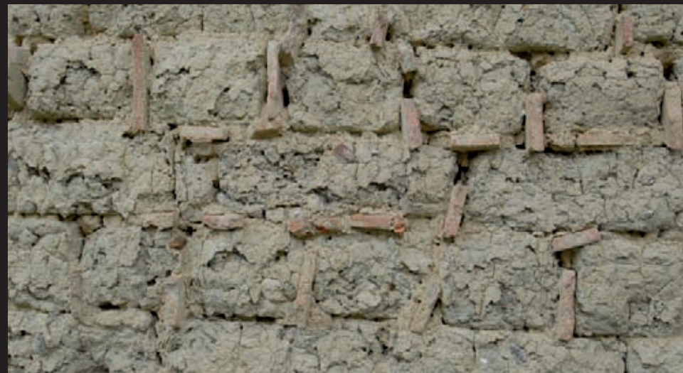
TRAKTÁRY A PŘÍRUČKY STAVITELSKÉ - VLIV: Hlína dusaná do bednění - Hildegardin dvůr kol. r. 1835; Pohořelice, Velký Dvůr čp. 223 * Úprava spar pro lepší přichycení omítky - Unterretzbach, Dolní Rakousy
