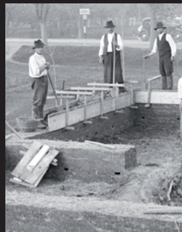
DUSANÁ HLÍNA / NABÍJENICE: Bedněň s příčňíky: Stavba pisé podle Rondeleta (1812) * Nástroje pro pisé podle Rondeleta (CRATerre) * Bedněň z Auvergne podle CRATerre * Stavba z dusané hlíny kolem roku 1930 v Maďarsku.
