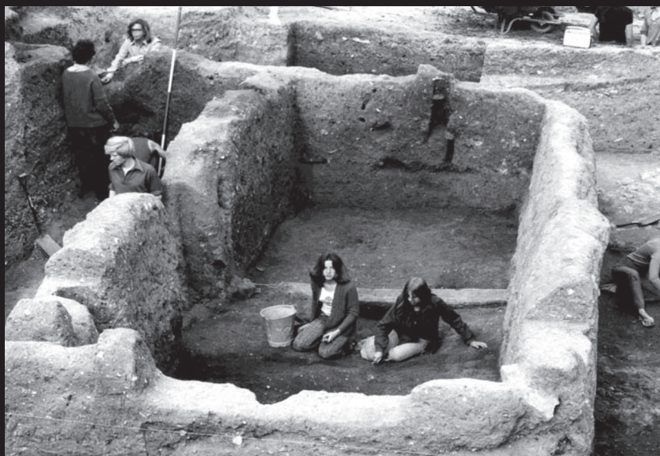
DUSANÁ NEBO VRSTVENÁ HLÍNA ?: Angle: Wallingford Castle (Oxfordshire); Robert Carr 1972 - stěny budovy o půdorysných rozměrech 8,5 x 12,5 m ze druhé poloviny 12. - počátku 13. století postavené technikou vrstvené hlíny „cob“ zachovány do výšky 1,8m (Chapelot Fossier 1980 Le Village et la maison au Moyen Age uvádějí jako příklad „pisé“)
