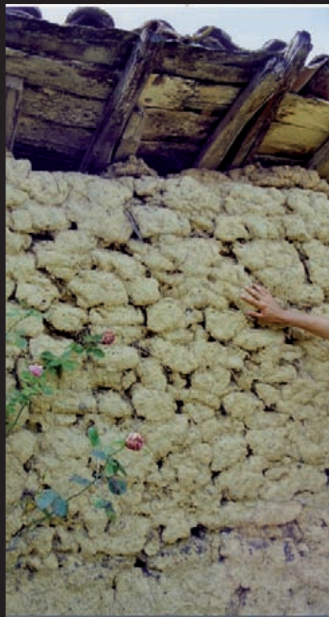
VRSTVENÁ HLÍNA / NAKLÁDÁNÍ / VRSTVENÉ VÁLKY: Vrstvení hliněných hrud * Francie: bauge / mottes de terre, pains de terre; gleba lutea: .hliněné bochníky z 15. a 10. - 11. stol.; neuspočádané hroudy - 14. století - archeologické nálezy z oblasti Languedoc - Roussillon * vernakulární stavby z 18.-19. století z okolí Toulouse
