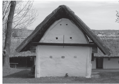
Unterschützen: granary – 1794 (KK).
