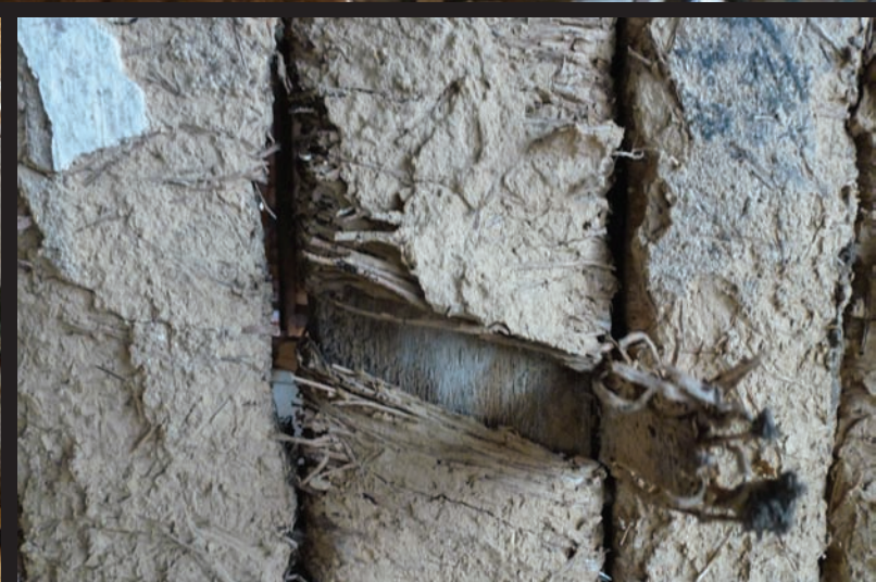
LEPENICE / KONSTRUKCE HRÁZDĚNÉ : Přízemní hrázděný dům z koce 18. století (1780 / 1783) s roubenou obytnou místností, dřevohliněným komínem a stropní konstrukcí hrázděné části z latí obalovaných slámou máčenou v hliněné břečce; Šluknov čp. 310 (Šluknov)
