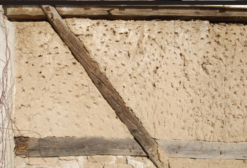
LEPENICE / KONSTRUKCE HRÁZDĚNÉ : Přízemní hrázděný dům z koce 18. století (1780 / 1783) s roubenou obytnou místností, dřevohliněným komínem a stropní konstrukcí hrázděné části z latí obalovaných slámou máčenou v hliněné břečce; Šluknov čp. 310 (Šluknov)
