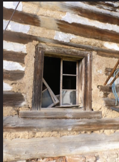
HLÍNA A ROUBENÉ KONSTRUKCE: Rychnov na Moravě (Moravská Třebová), čp. 137 (kol. r. 1775); hlínou vymazané spáry zajištěné dřevěnými kolíky.
