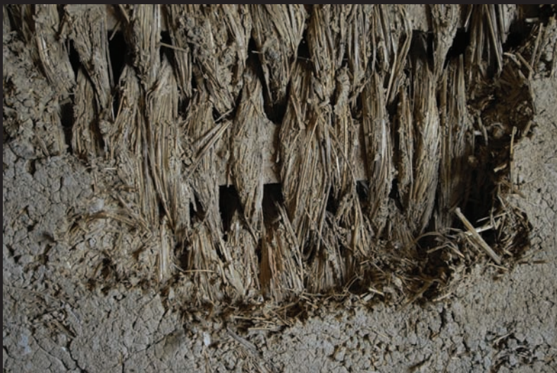
LEPENICE / KONSTRUKCE HRÁZDĚNÉ: Patrový hrázděný, částečně zděný dům s roubenou obytnou místností z roku 1727; Lipová u Šluknova čp. 424 (Lipová)
