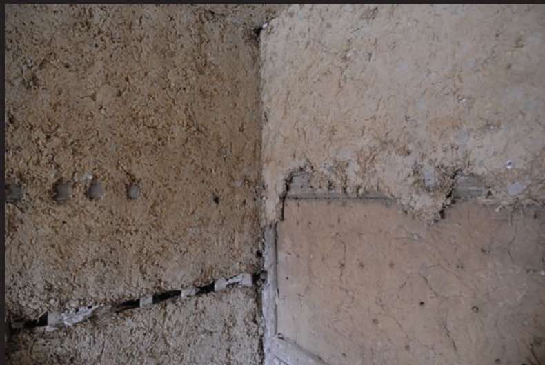
LEPENICE / KONSTRUKCE HRÁZDĚNÉ: Patrový hrázděný, částečně zděný dům s roubenou obytnou místností z roku 1727; Lipová u Šluknova čp. 424 (Lipová)
