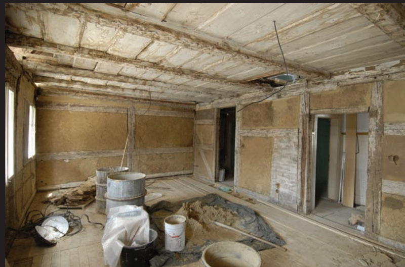
LEPENICE / KONSTRUKCE HRÁZDĚNÉ: Patrový hrázděný, částečně zděný dům s roubenou obytnou místností z roku 1727; Lipová u Šluknova čp. 424 (Lipová)
