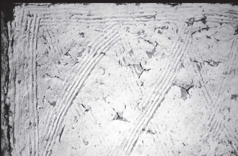
LEPENICE / KONSTRUKCE HRÁZDĚNÉ: Úprava povrchu - Holešice (Jirkov) * Skalsko (Bělá pod Bezdězem) * Šluknov (Šluknov)
