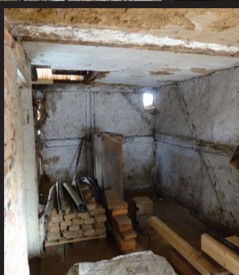
LEPENICE / KONSTRUKCE HRÁZDĚNÉ : Přízemní hrázděný dům z koce 18. století (1780 / 1783) s roubenou obytnou místností, dřevohliněným komínem a stropní konstrukcí hrázděné části z latí obalovaných slámou máčenou v hliněné břečce; Šluknov čp. 310 (Šluknov)
