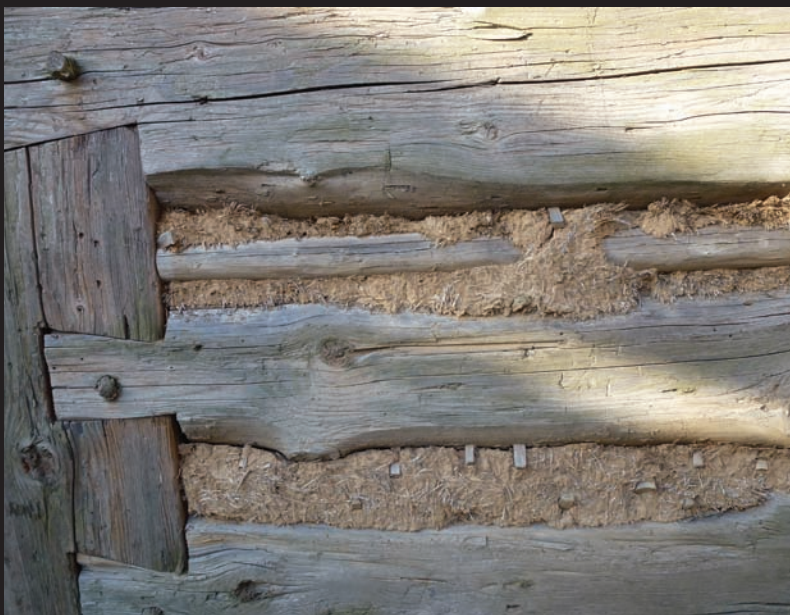
HLÍNA A ROUBENÉ KONSTRUKCE: Rychnov na Moravě (Moravská Třebová), čp. 137 (kol. r. 1775); hlínou vymazané spáry zajištěné dřevěnými kolíky.
