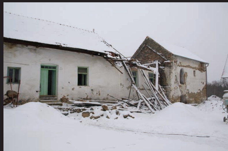
OBYTNÁ MÍSTNOST V „KOŽICHU“: Mirkovice (Velešín), Český Krumlov, dům usedlosti čp. 1 s hliněnou omazávkou štítového průčelí obytné místnosti (1422–1430)
