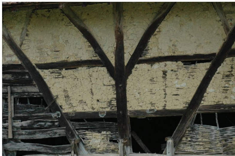
LEPENICE / KONSTRUKCE HRÁZDĚNÉ: Příklady Francie (Bresse, Agenais, Occitanie)
