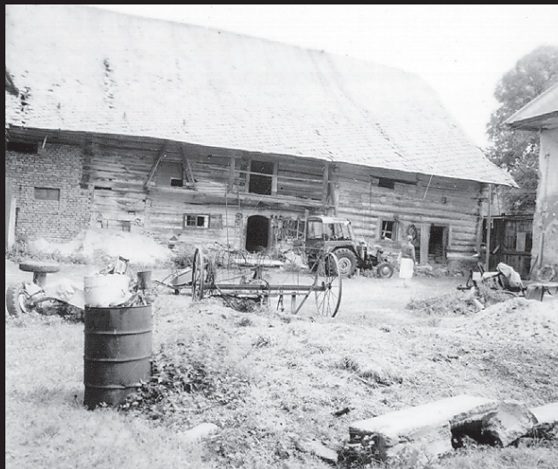
HLÍNA A ROUBENÉ KONSTRUKCE: Rychnov na Moravě (Moravská Třebová), čp. 137 (kol. r. 1775); hlínou vymazané spáry zajištěné dřevěnými kolíky.
