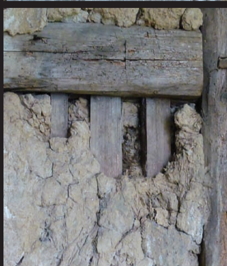
LEPENICE / KONSTRUKCE HRÁZDĚNÉ : Přízemní hrázděný dům z koce 18. století (1780 / 1783) s roubenou obytnou místností, dřevohliněným komínem a stropní konstrukcí hrázděné části z latí obalovaných slámou máčenou v hliněné břečce; Šluknov čp. 310 (Šluknov)
