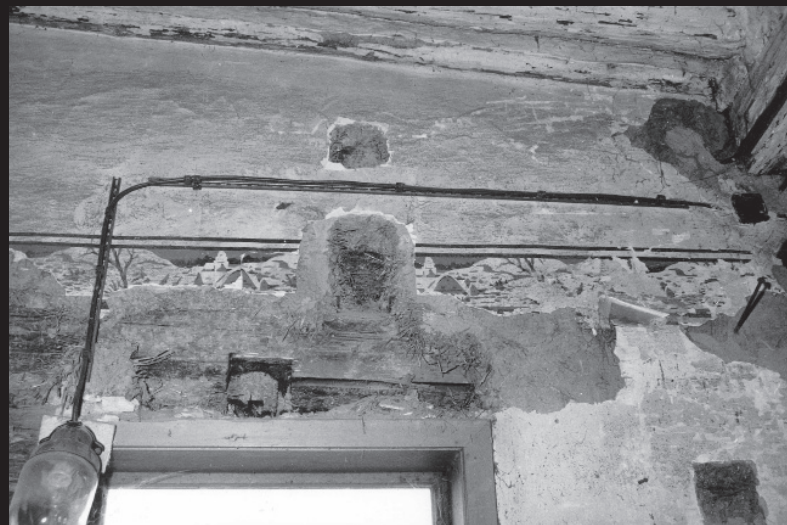
OBYTNÁ MÍSTNOST V „KOŽICHU“: Vračovice, Ústí nad Orlicí, dům usedlosti čp. 2 (dymná jizba - 1538) * SHP (Škabrada, J. - Syrová, Z. 2018. Nejstarší venkovské domy ve východních Čechách . 2018; 86–107) * analýza rostlinných příměsí omazávek (Tintner, J. et al. 2020. Clay Bricks and Plasters - Can We Use Its Molecular Decay for Dating Purposes? in Molecules 25, 1419.)
