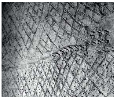
Obr. 21: Praha, Nové Město čp. 412. Diagonální rýhování a důlkování na povrchu hliněné omazávky roubené obytné místnosti bývalé podskalské celnice. (Foto J. Škabrada 1984)
