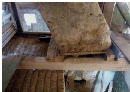
Obr. 5: Šluknov (Šluknov) čp. 310. Dřevohlinitý komín a stropní konstrukce z latí obalovaných slámou máčenou v hliněné břechce. (Foto Z. Syrová 2011)
