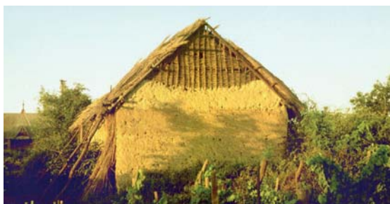
Obr. 2a, b: Dolný Peter, Slovensko. Vinné budy z vrstvené hlíny s vyplétanými, částečně omazanými štíty. (Foto Z. Syrová 1990)
