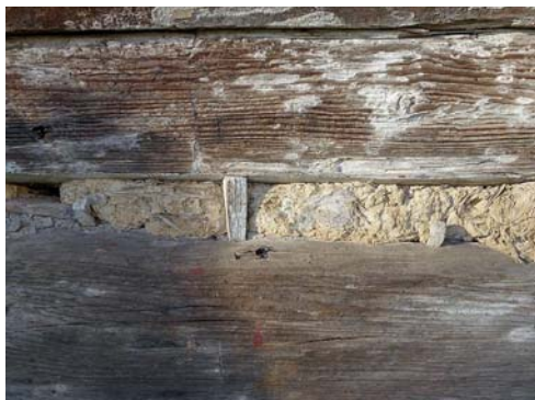
Obr. 9: Rychnov na Moravě (Moravská Třebová) čp. 137. Detail vymazané spáry. (Foto Z. Syrová 2016)
