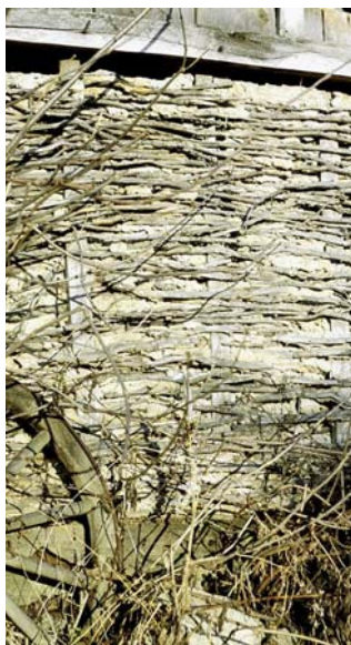
Obr. 1: Lančár, Slovensko. Vyplétaná, na vnitřní straně omazaná stěna stodoly. (Foto Z. Syrová 1987)
