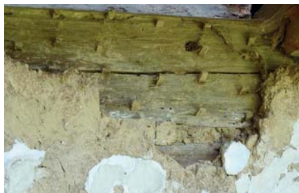
Obr. 10: Čistá (Litomyšl) čp. 171. Detail ježkování pod omazávkou zadní části domu z konce 17. století. (Foto Z. Syrová 2016)
