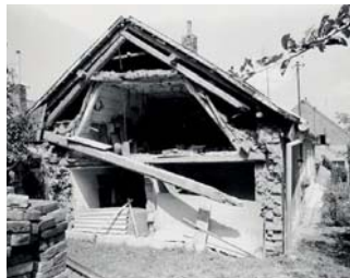
Obr. 19: Lysovice (Vyškov) čp. 63. Řez komorovou částí domu s podstřešním lepenem v době rekonstrukce. (Foto Z. Syrová 1997)
