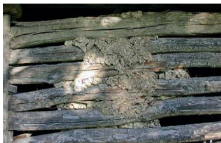
Obr. 12: Těšov (Uherský Brod). Omazávka na neodkorněných kuláčích vinné bůdy rámové konstrukce se zaroubenými nárožími. (Foto Z. Syrová 2001)
