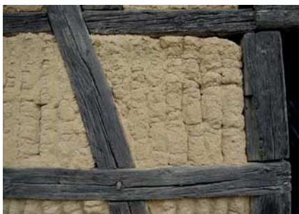
Obr. 6: Écomusée d'Alsace, Ungersheim, Francie. Dům z r. 1561 z Artolsheimu. Výplň hrázdění ze svislých tyčí omotávaných slámou máčenou v hliněné břechce. (Foto Z. Syrová 2019)
