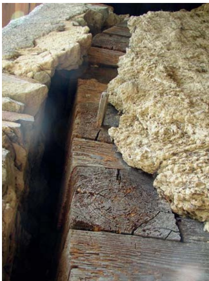
Obr. 15: Mirkovice (Velešín) čp. 1. Omazávka štítového průčelí srubu obytné místnosti. (Foto P. Bureš 2010)
