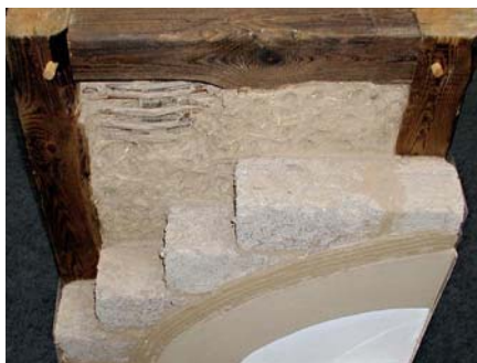
Obr. 3: Přezdívková deska z cihel z nepálené hlíny omítnutých hliněnou omítkou.
