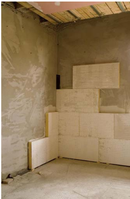
Obr. 5: Lepení vnitřní tepelné izolace vždy na vyrovnaný podklad.
