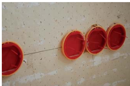
Obr. 7: Montáže elektrických rozvodů, krabic a vypínačů musí být vzduchotěsné.
