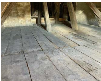
Obr. 17: Úprava a navrácení původních prken na konstrukci. Zachování historického rázu celého podkroví
