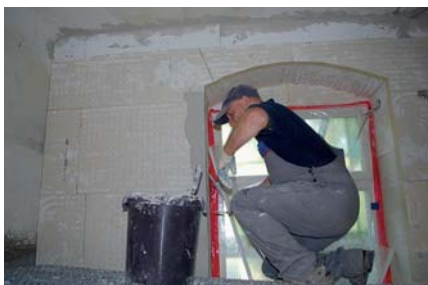
Obr. 4: Montáž desek z polymerní pěny.
