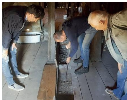
Obr. 12: sonda do konstrukce stropu – nutná pro zjištění stavu konstrukce a přesnějšího návrhu sanace.
