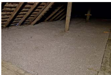
Obr. 5, 6: Zámek Mlýnský, zateplení půdy způsobem volného foukání.
