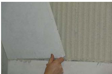
Obr. 2: Lepení kalciumsilikátových desek na sraz metodou floating.
