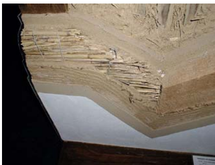
Obr. 4: Tradiční hliněná omítká nanesená na rohoži z rákosu (tzv. rákosová omítková rohož / rákosovina).
