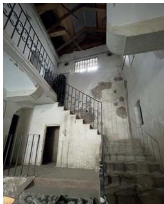
Obr. 5: Vnitřní prostor historického objektu, obvodové zdivo (původní hradební konstrukce) pod úrovní vnějšího upraveného terénu.
