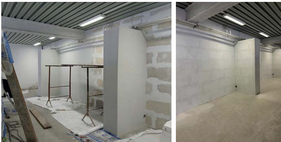
Obr. 14, 15: Příklad realizace kapilárně aktivního zateplovacího systému u obvodové konstrukce zcela pod úrovní vnějšího upraveného terénu.
