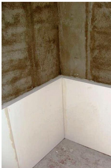
Obr. 1: Kalciumsilikátové desky v uspořádání na vnitřním koutě místnosti.
