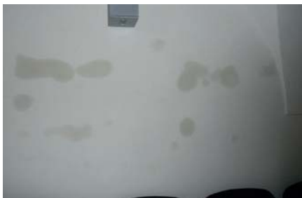
Obr. 7: Projevy kondenzace na obvodové stěně historického objektu.
