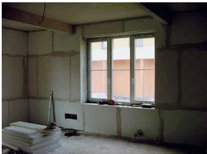
Obr. 3: Uspořádání kalciumsilikátových desek kolem okna.
