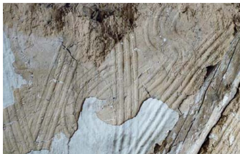
Obr. 20: Šluknov (Šluknov) čp. 310. Rýhování povrchu lepenicové výplně hrázděné stěny komorové části domu z 80. let 18. stol. (Foto Z. Syrová 2011)
