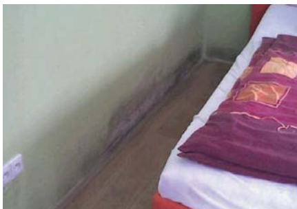
Obr. 9: Kondenzační poruchy u svislé konstrukce ve 2. NP.
