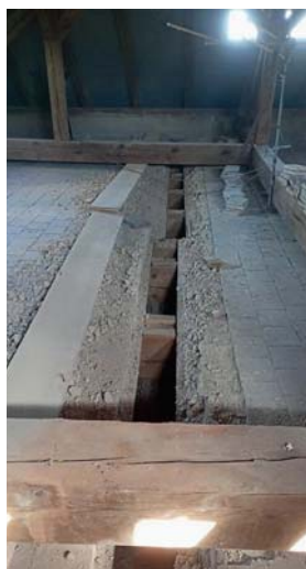
Obr. 24: Vytvoření aplikačního otvoru do dutiny stropu.
