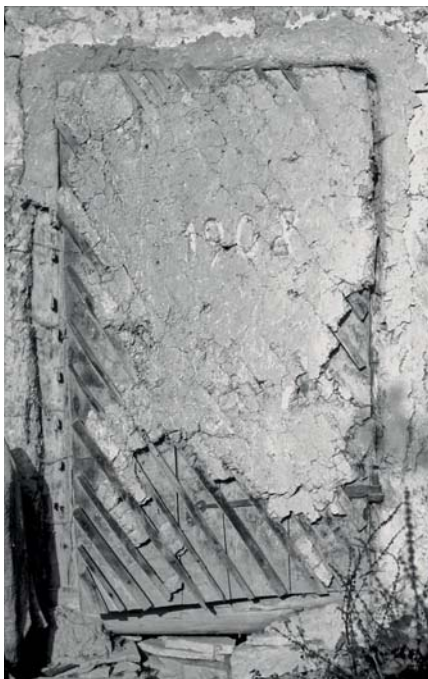
Obr. 11: Lenartov, Slovensko. Dveře komory s datováním 1908 vykresleným prstem v omazávce provedené na šikmém laťování. (Foto Z. Syrová 1988)
