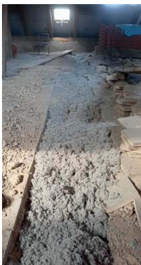
Obr. 25: Zateplení dutiny stropu.
