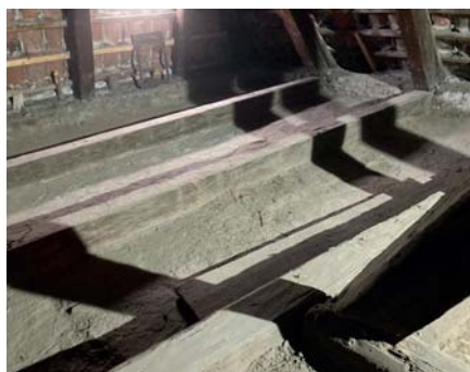
Obr. 14: Odstranění suti, vyčištění izolačního prostoru.
