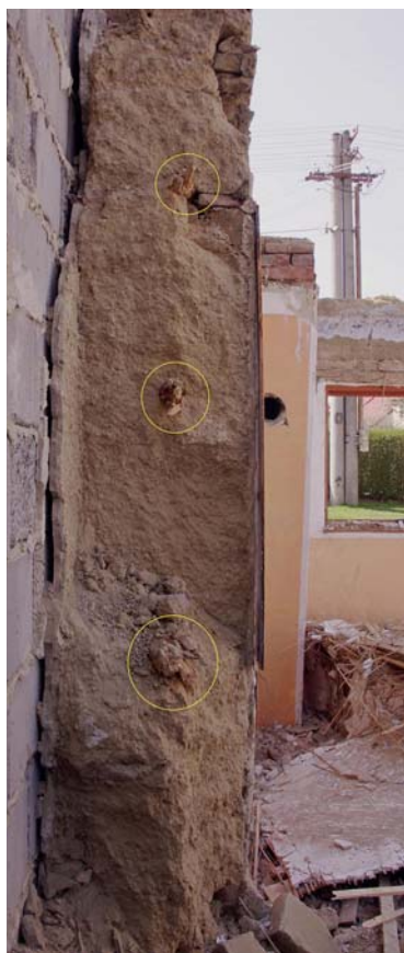
Obr. 2: Vnorovy čp. 481 – trámové kleštiny domu – zvýrazněno. (Foto autor 2016)
