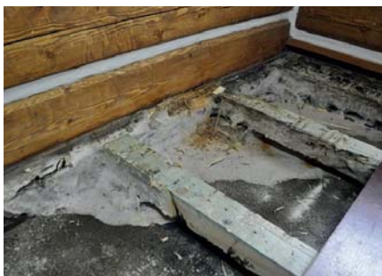
Obr. 3: Prostory rekreační chalupy z obr. 2 zachvácené myceliem dřevomorky.
