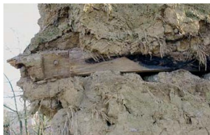
Obr. 6: Tištin čp. 13 – detail sekundárně použitého dřevěného prvku ve stěně válkové stodoly. (Foto autor 2012)
