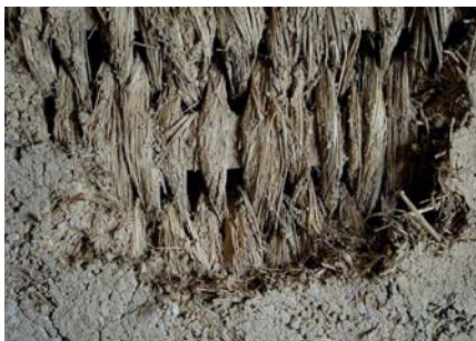
Obr. 4: Lipová (Lipová) čp. 424. Hrázděná stěna se slaměným výpletem. (Foto J. Syrový 2011)
