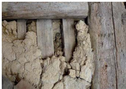
Obr. 3: Šluknov (Šluknov) čp. 310. Omazávka hrázděné konstrukce dvorní stěny domu. (Foto Z. Syrová 2011)
