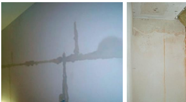
Obr. 20, 21: Příklady poruch vnitřního zateplení.
