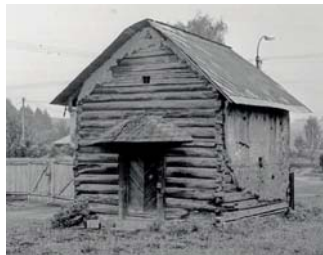
Obr. 17: Kobeřice (Hlučín) čp. 13. Sýpka s roubenou valenou klenbou. (Foto Z. Syrová 1989)
