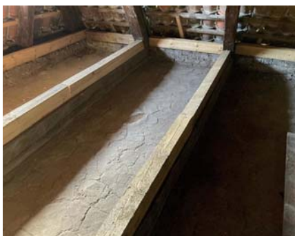
Obr. 15: Navýšení výšky izolačního prostoru pomocí dřevěných trámek na 40 cm.
