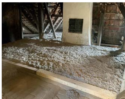
Obr. 16: Bezspará vrstva izolace, odstranění tepelných mostů.
