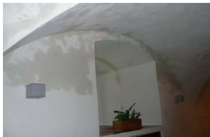
Obr. 8: Projevy kondenzace u stejného objektu v rozsahu obvodového zdiva i stropních konstrukcí.
