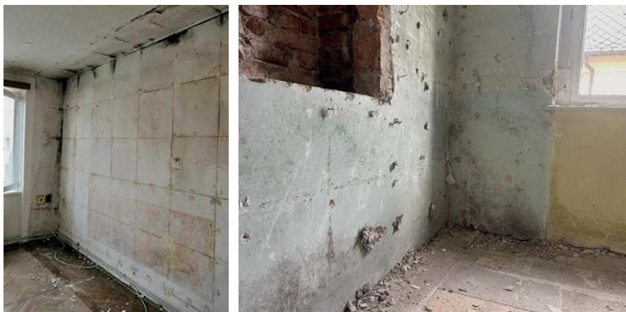
Obr. 1, 2: Stav obvodového zdiva po sejmutí obkladu z EPS – vztlínající vlhkost v kombinaci s kondenzací, neodborné provedení.
