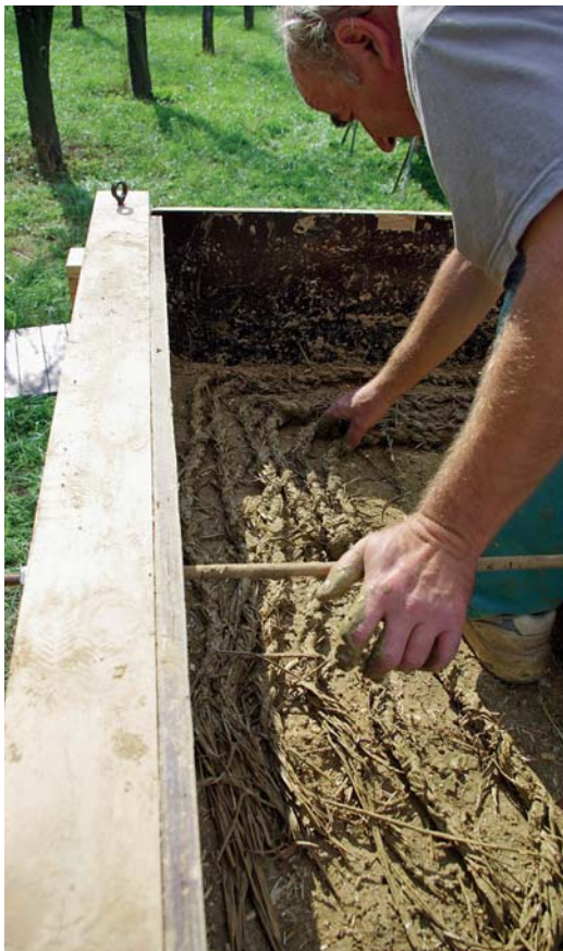
Obr. 7: Skanzen Strážnice – výztuž nároží slaměnými povříslu u experimentální stavby. (Foto autor 2012)
