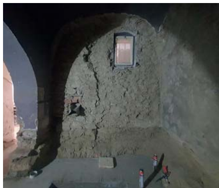
Obr. 3: Nesourodé, vlhké zdivo pod úrovní vnějšího upraveného terénu u historického objektu s požadavkem na zlepšení tepelnětechnických parametrů.
