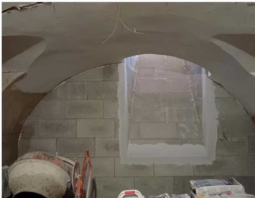
Obr. 12: Realizace vnitřního zateplení kapilárně aktivními deskami v historickém objektu u zdiva pod úrovní vnějšího upraveného terénu.
