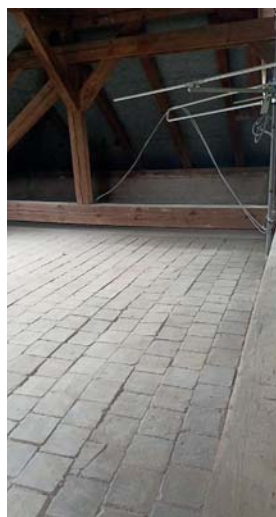
Obr. 26: Zapravení podlahy původními půdovkami.
