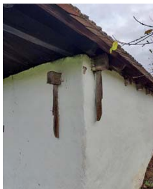
Obr. 4: Skanzen Strážnice – detail vyčnívajícího trámu zajištěného dřevěnou závlačí. (Foto autor 2025)
