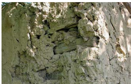
Obr. 5: Tištin čp. 13 – prokládání nároží stodoly dřevěnými prvky. (Foto autor 2012)
